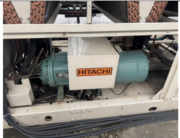
Compressor 01 – Desativado/Danificado
